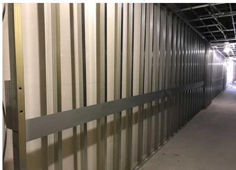
▼7階共用廊下 天井・壁下地施工状況
