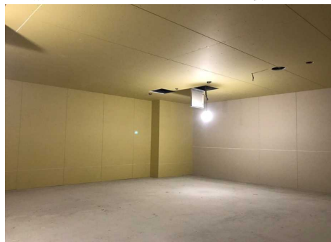
▼3階トランクルーム 天井・壁ボード施工状況
