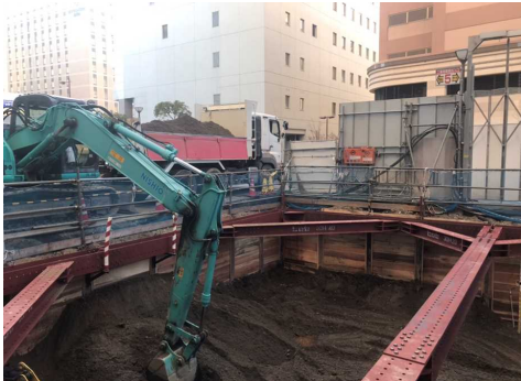
▼防火水槽二次掘削状況
