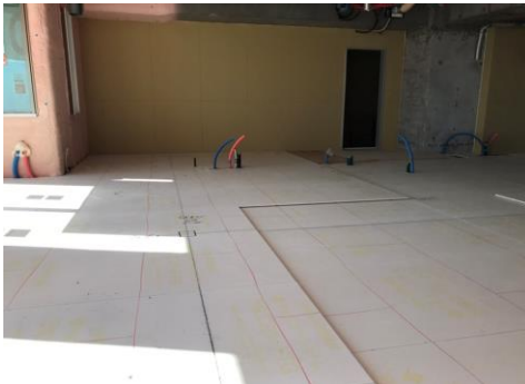
▼20階住戸内置き床施工状況
