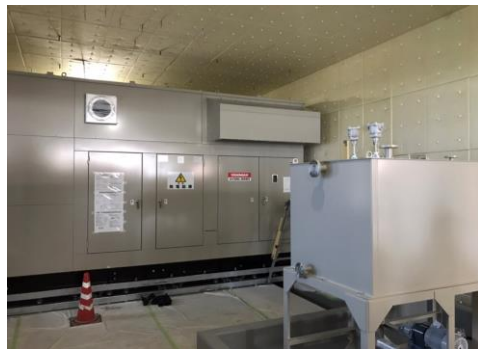
▼3階自家発電気室発電機設置状況
