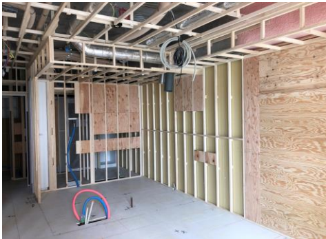
▼8階住戸内壁・天井木軸下地壁施工状況
