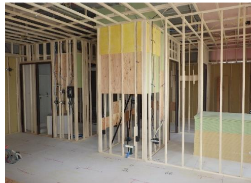
▼6階住戸内壁・天井木軸下地施工状況
