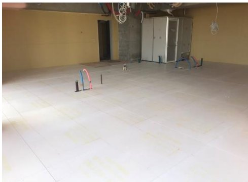
▼9階住戸内置き床施工状況
