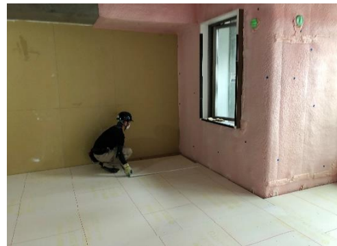
▼5階住戸内置き床施工状況
