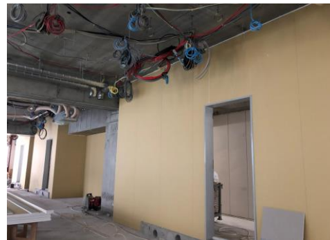
▼5階乾式耐火遮音間仕切り壁施工状況
