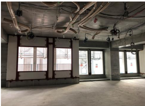
▼6階外壁ALC・アルミサッシ・ガラス取付状況
