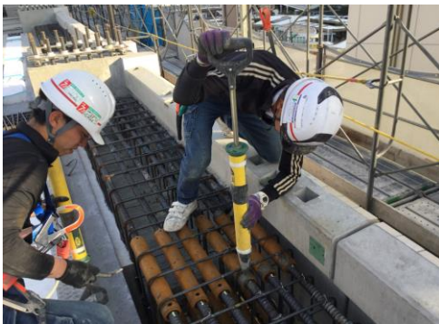
▼7階床梁（2工区）主筋接合部グラウト注入状況
