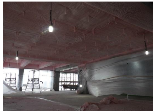
▼2階天井断熱材吹付状況状況
