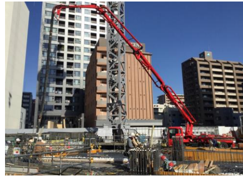
▼1階床（4工区）監理者配筋検査状況
