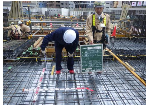
▼1階床（4工区）監理者配筋検査状況
