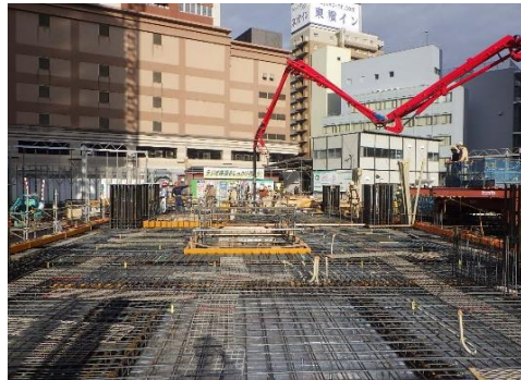
▼1階床（2工区）監理者配筋検査状況
