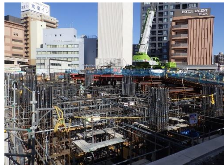
▼免震上部基礎～1階柱・梁配筋状況
