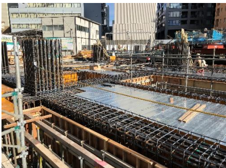
▼1階床型枠デッキ敷設状況
