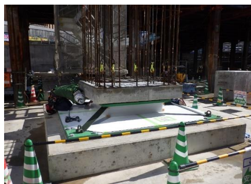
▼免震上部基礎サイトPC据付け状況
