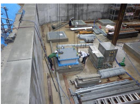
▼免震装置据付け状況
