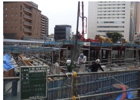
▼免震上部基礎サイトPC据付け状況
